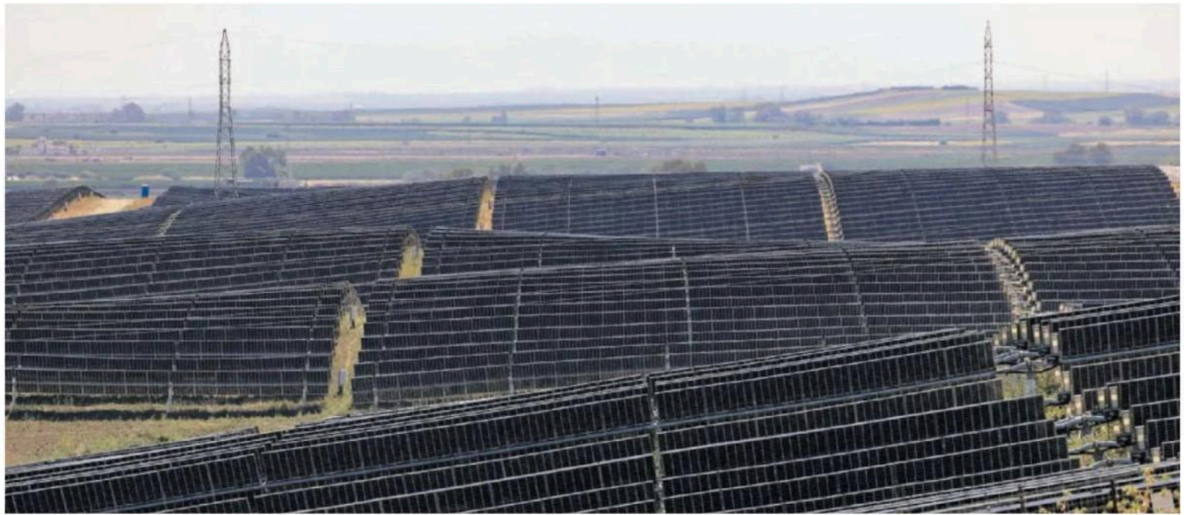
Placas solares en el término municipal de Guillena (Sevilla). PACO PUENTES
